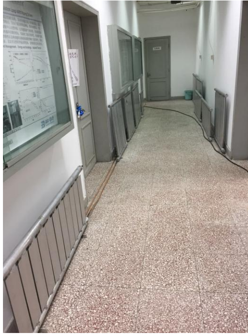
图3 多联式热泵/热管复合式空气源热泵机组实际测试图
